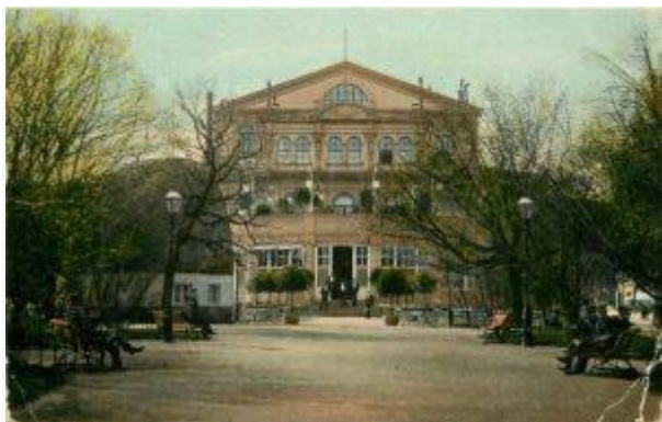
El antiguo edificio que albergó la Ópera de Helsinki hasta inicios del siglo XX.
