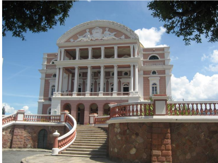
Vista del Teatre d'Amazonas de Manaus: Un edifici espectacular en un entorn insòlit
